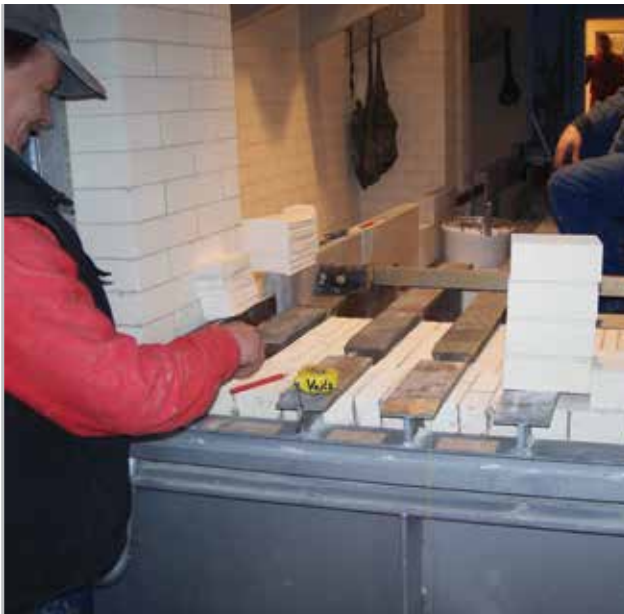
Montage einer Ofenanlage
