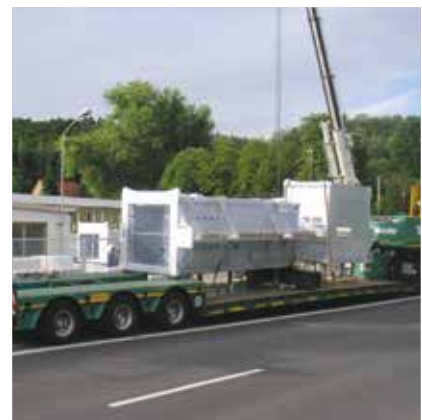
Verladen eines vormontierten Rollenofens
