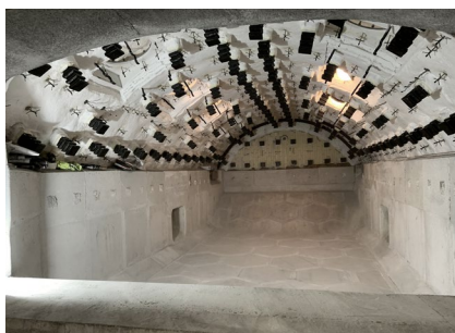
Aluminiumschmelzofen während der Montage
